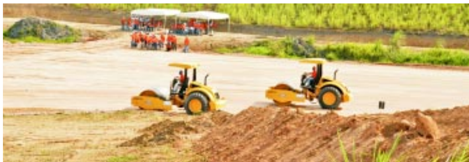
FORMAÇÃO – Trabalhadores de obras terraplenagem tiveram capacitação do SENAI
